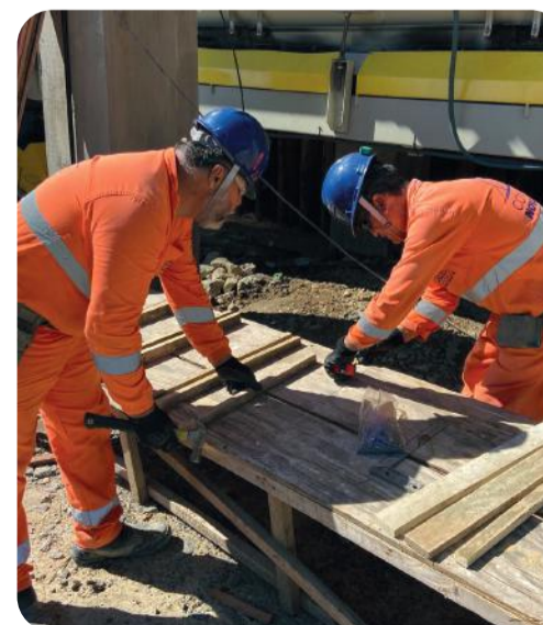
Atividade sendo realizada no Canteiro Industrial Imagem: CSPG.
