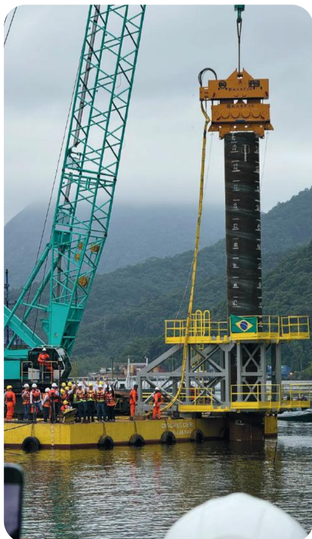
Camisa metálica sendo colocada para fundação da ponte. Imagem: CSPG.
